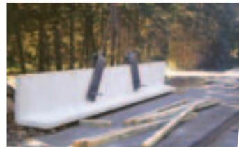
Manutention par broches transversales avec clavettes.
