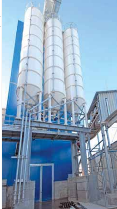
Les trois silos à ciments et à filler dominent littéralement le site de Malataverne.
