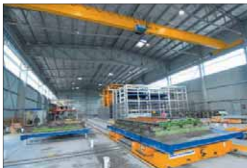
Le nouveau hall abritant le carrousel se développe sur une surface de 2 430 m 2 (27 m x 90 m).
