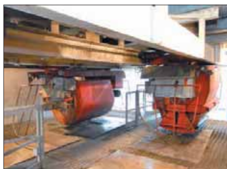
Les deux télé-bennes – une basculante à cuve fermée et une à ouverture par casque – permettent le transport du béton jusqu'aux zones de préfabrication.
